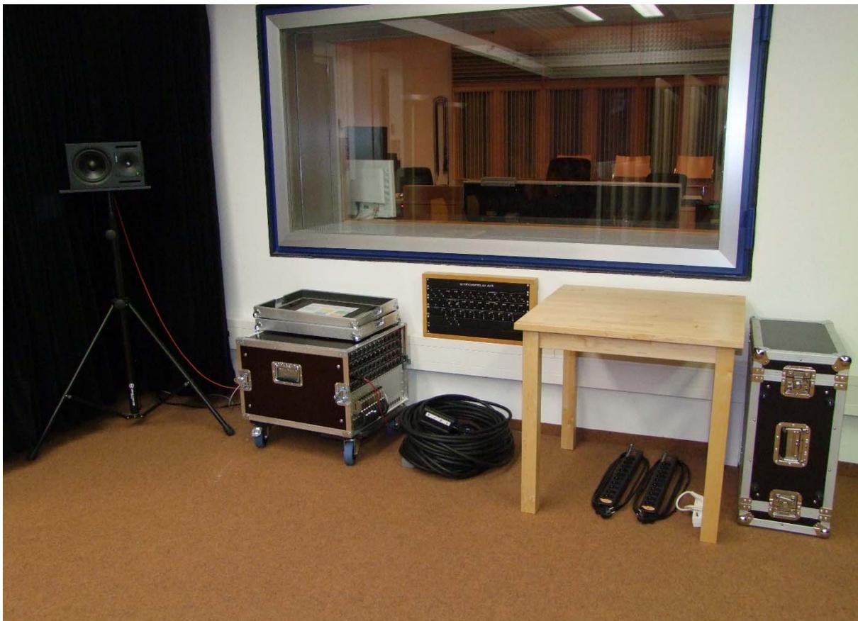
Abb. 12: Korrekte Aufstellung von Monitor-Lautsprecher, Dallis-Einheit, Multicores, Steckerleisten, Studiotisch und Kopfhörer-Rack, mit unverdeckter Anschlussblende AR
